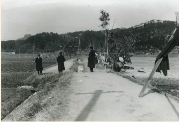
郷村断層(まっすぐだった道が、地震によってずれている様子が見える)
